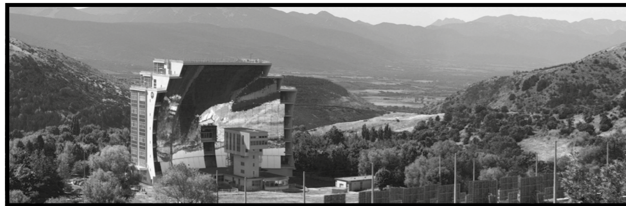
4. ábra: Parabolatükör naperőmű a Pireneusokban (Forrás: www.wikipedia.org; H. Zell felvétele)
