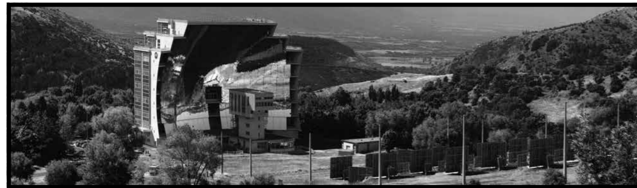
2. Slika: Solarna elektrana sa paraboličnim ogledalom u Pirinejima. (Forrás: www.wikipedia.org; H. Zell felvétele)
